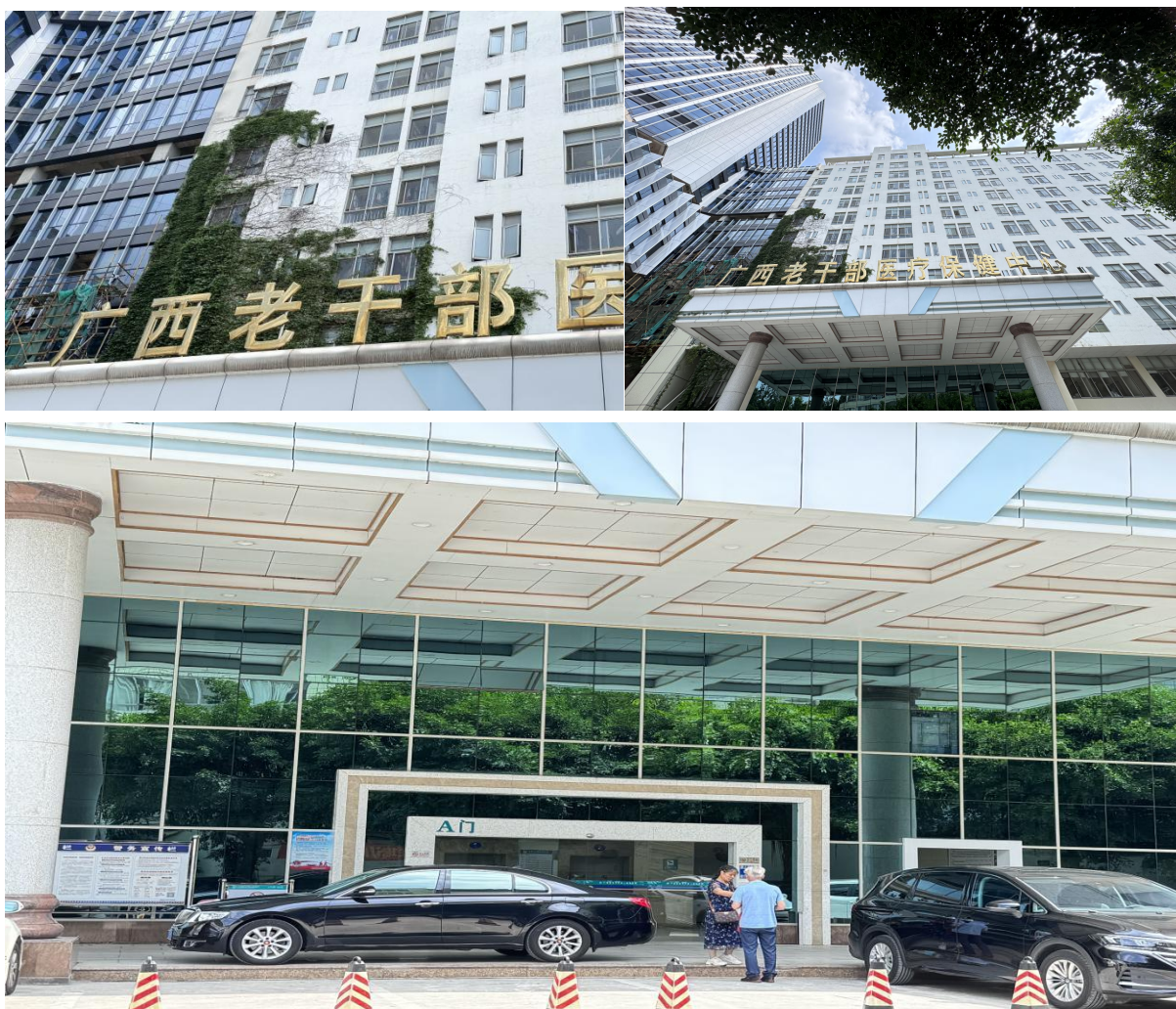
广西老干部医疗保健中心（2号楼）
